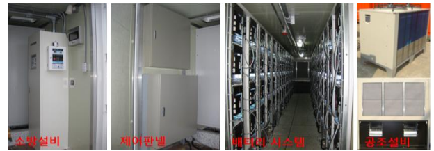
그림 6. 500kWh BCS 내부 구성품의 모습
