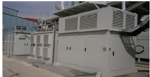
그림 4 현장 적용된 3MW급 EBOP 시스템(PCU Leader)
