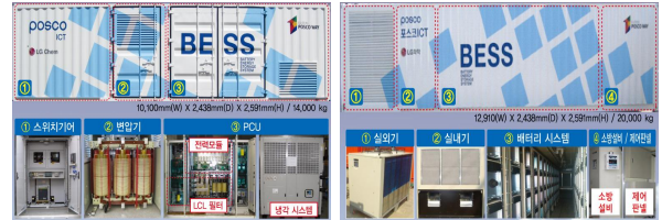
그림 6. 2MVA BESS
