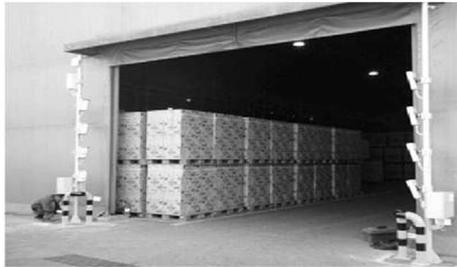
[그림 9] 입출고 Unit Load RFID Tag Pallet 인식 조정 전 안테나 위치
