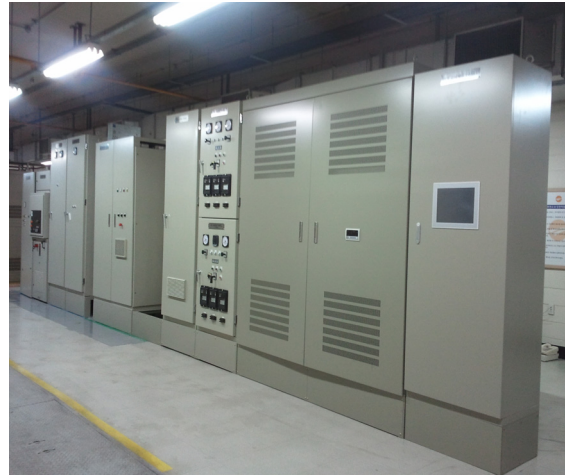
〈그림 5〉 회생용 인버터 현장 설치
