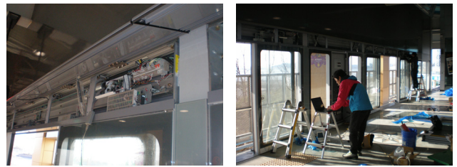
〈그림 5〉 승강장 스크린도어에 제어기를 설치한 모습(좌)과 현장설치 시험을 한 장면(우)
