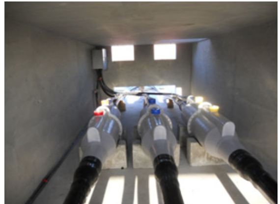
〈그림 10〉 400kV XLPE 2500SQ 소선절연 조립식 접속함 시공
