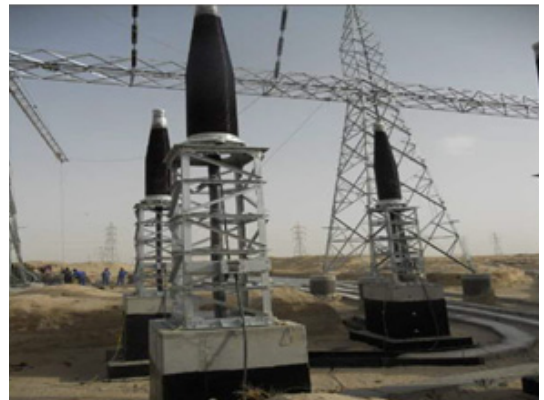
〈그림 11〉 400kV XLPE 2500SQ 소선절연 기중중 종단접속함 시공
