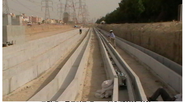
〈그림 7〉 콘크리트 Trough내 케이블 설치
