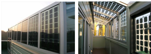
〈그림 1〉 분석모듈 설치 전경 (외부, 내부)
