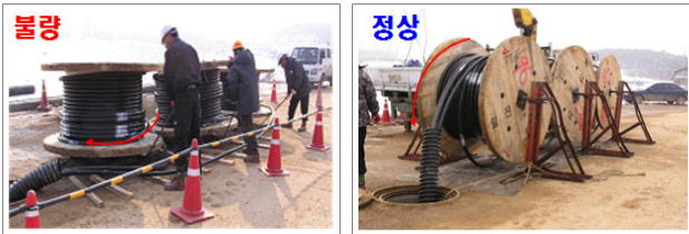
〈그림 5〉 케이블 Pulling
