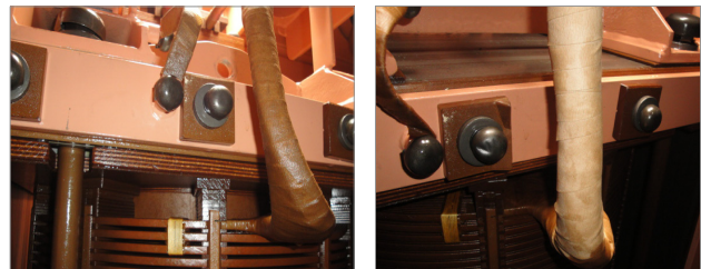
(c) 권선리드 변형 사진 (d) 권선리드 보강후 사진
