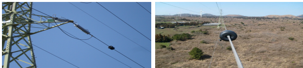
<그림 3> 불센서 설치 사진
