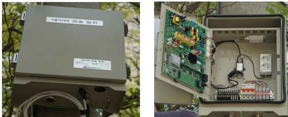
〈그림 4〉 DCU 설치 외관 및 내부
