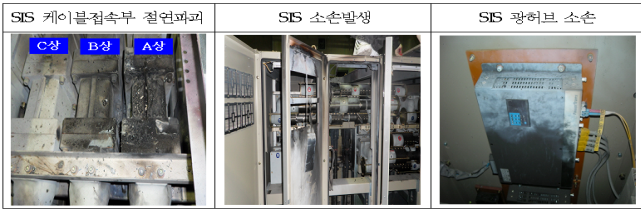
〈그림 3〉 25.8kV SIS 고장 사진
