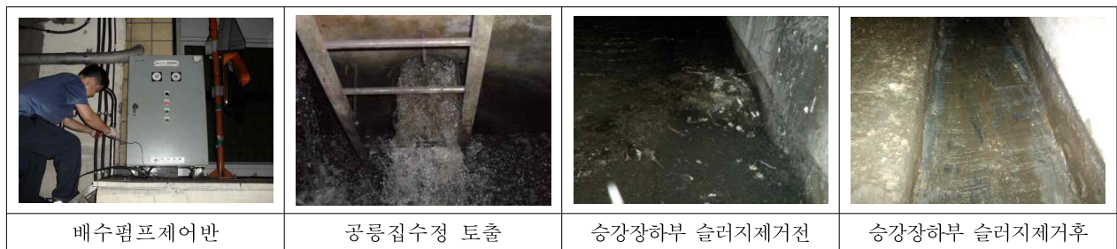
(Figure 2) 배수로 수중펌프 설치 및 승강장 하부 슬러지 제거과정
