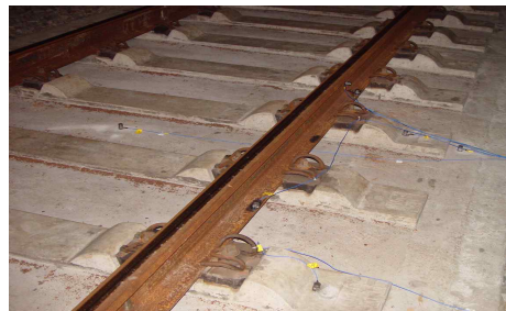
그림 4 콘크리트 궤도의 레일 및 침목의 진동 측정
