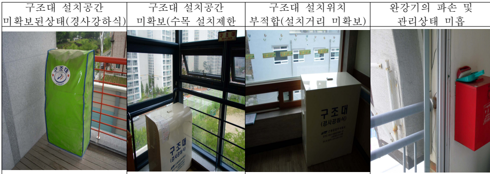
사진 2 전시용으로 설치된 피난기구
