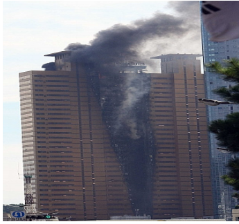
사진 1. 부산 해운대 38층 우신골드스위트 건물 화재
