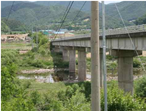
그림 1. 송강수위 관측소 전경
