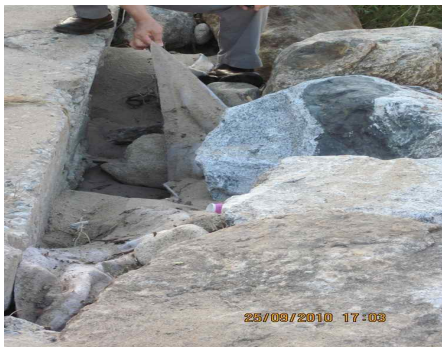
저수로 호안공의 유실 모습
