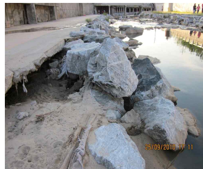
저수로 호안공의 유실 모습
