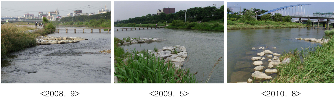
그림 3. 무심천 하상에 설치된 수제
