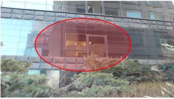
그림 6. 역삼동 A빌딩 3층 복도 창호
