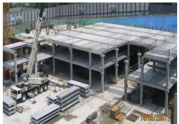
그림 2. MRS공법 적용현장 전경
