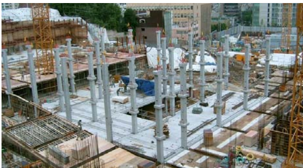
그림 10. 지하3층 바닥부재 조립
