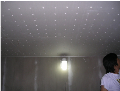
Figure 2 타공석고보드 시공장면
