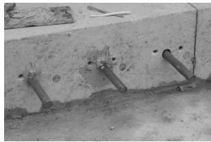
그림 3. 다웰바 및 타이바 설치
