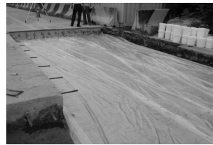
그림 4. 하부지반 비닐 설치
