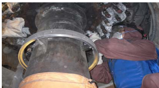
[그림 1. 가압기 이중 금속부 Overlay 작업사진]
