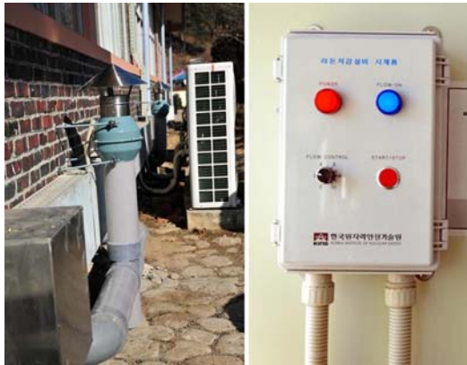
그림 1. 설치된 라돈 저감 설비 시제품 및 control box
