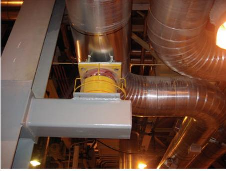
그림 5 Viscous 댐퍼 설치
