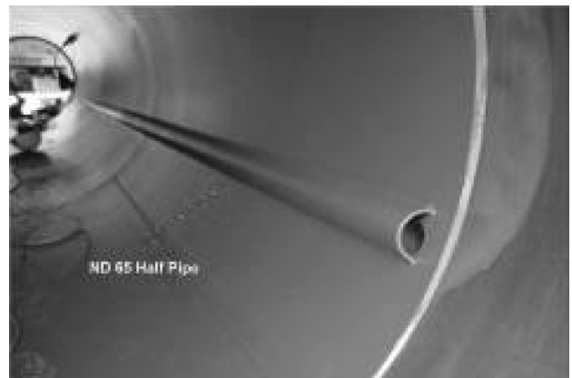
Fig. 6 Cable 유도를 위한 Half Pipe
