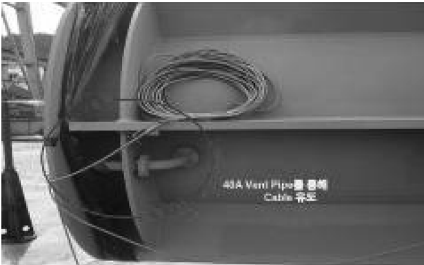
Fig. 7 Cable 유도를 위한 Vent Pipe
