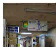
천정에 설치된 모습으로 평상시 비상구가 있음을 표시하는 기능만을 수행
