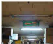
천정에 설치된 모습으로 평상시 비상구가 있음을 표시하는 기능만을 수행
