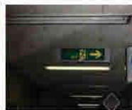
천정에 설치된 모습으로 평상시 비상구가 있음을 표시하는 기능만을 수행
