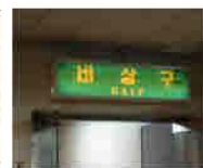
천정에 설치된 모습으로 평상시 비상구가 있음을 표시하는 기능만을 수행
