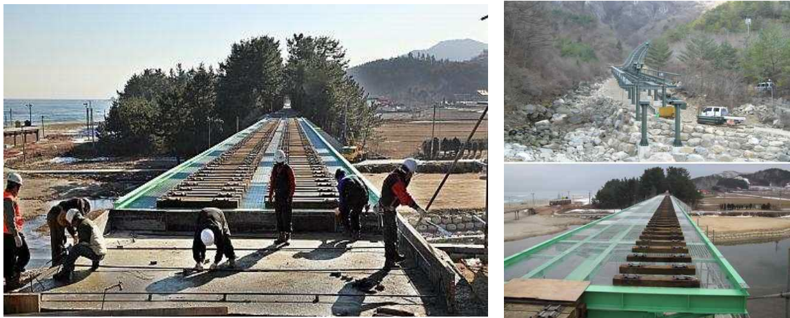
그림 4. 삼척시 해양레일바이크 교량 설치 공사 현장
