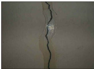
사진 1. 구조물 거동으로 인한 균열발생
