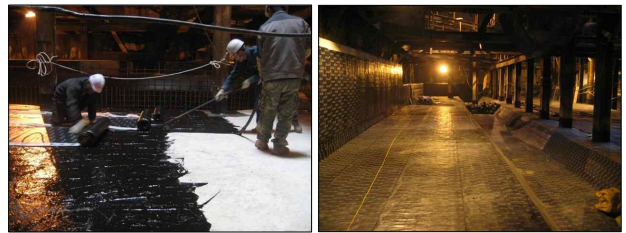
(a) 점착유연형 도막재 시공
