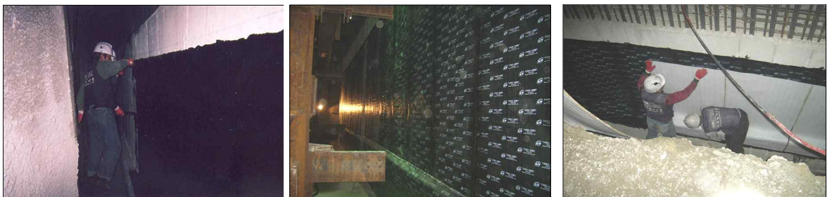
(a) 점착유연형 도막재 시공
