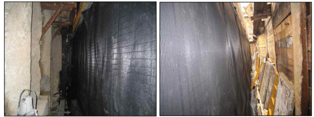
(c) 보호층 시공-1
