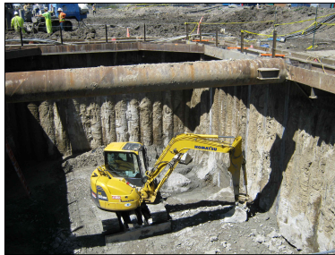
사진 9. 지하 터파기 현황
