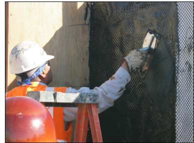
사진 10. 점착 유연형 도막재 시공
