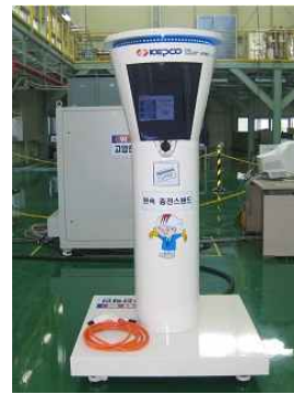
(b) 한국전력공사 (KEPCO) 완속충전기
