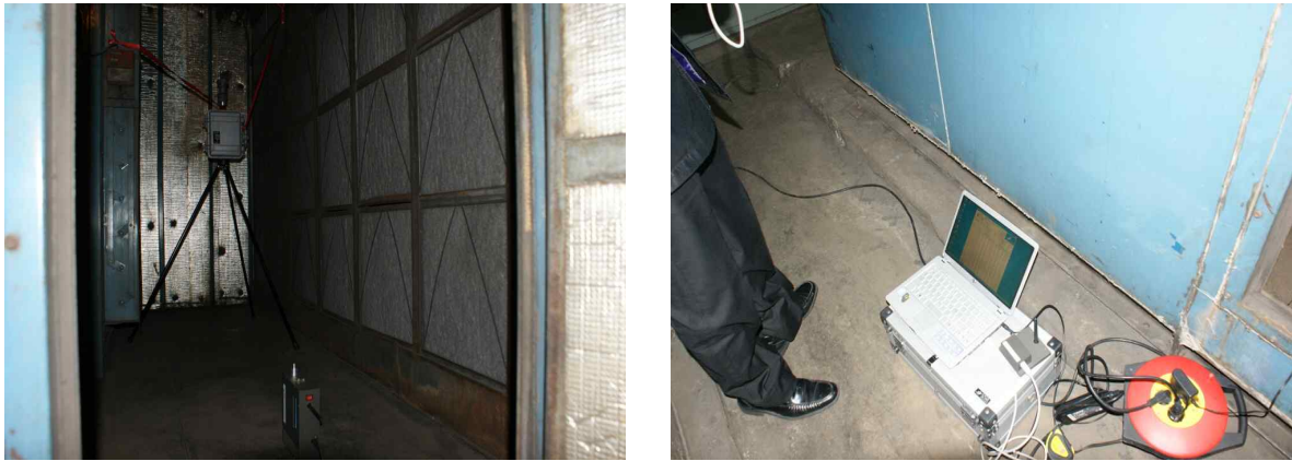
그림 3-2 PMX-II 설치 및 데이터 전송
