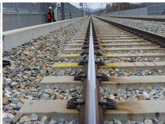
Figure 18 용접부 국부 연마 후
