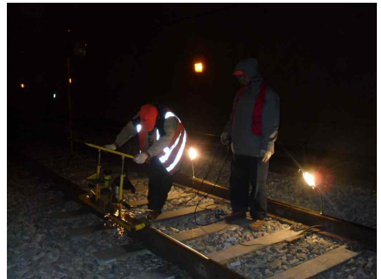
Figure 16 인력에 의한 국부적 레일연마
