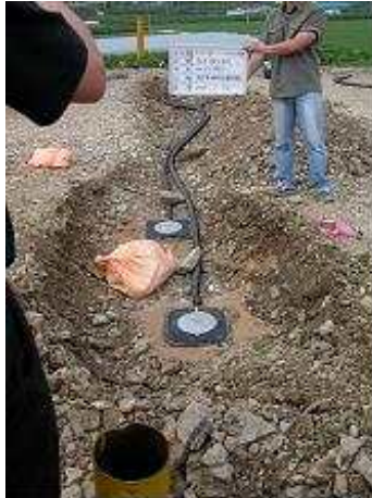
<사진 1> 토압계 설치 전경
