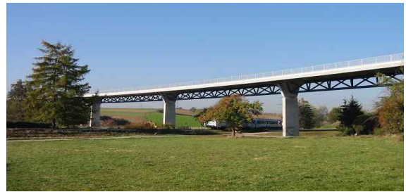
그림 3. 강관 트러스 합성형 교량 (Korntal-Munchingen Bridge, 독일)
