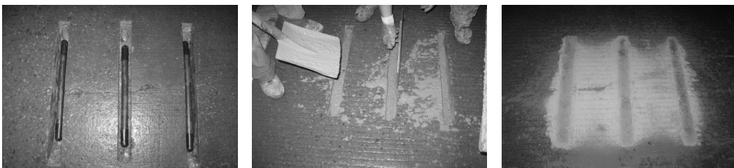
그림 6. 다웰바 설치(좌측부터 : 다웰바 거치, 채움재 포설, 시공 완료 모습)
