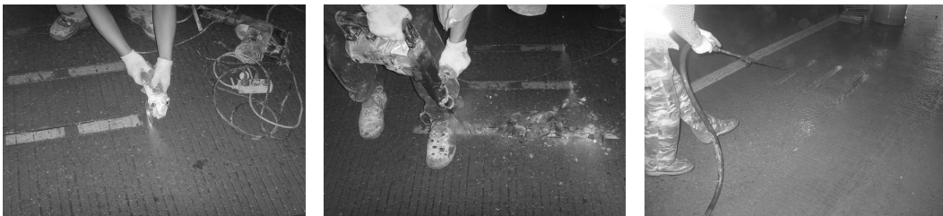
그림 5. 슬롯 시공(좌측부터 : 슬롯 위치 절삭, 슬롯 내부 파쇄, 고압 물청소)
