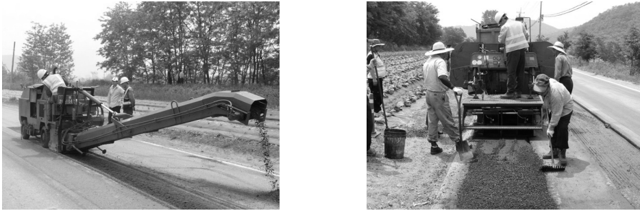
그림 2. 최소단면 보수공법용 장비(소형절삭기 및 피니셔)
