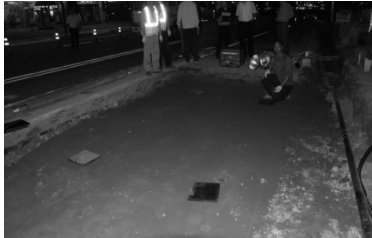
그림 5. 지반평탄화 후 지지판 설치
