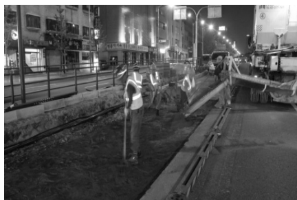
그림 4. 하부지반 평탄화 작업
