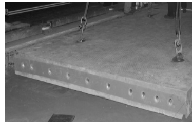
그림 8. 다웰바 접합부 스펀지 부착
