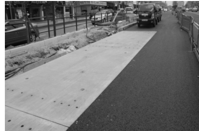
그림 12. 기존 포장 접합부 처리
