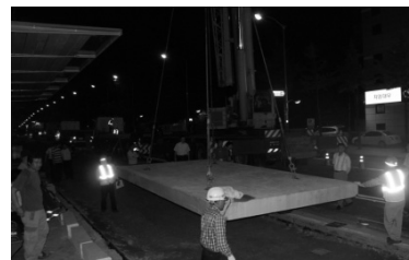
그림 10. 슬래브 양중 작업
