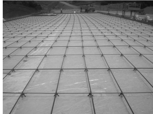
② PS강연선 및 보조철근 설치
