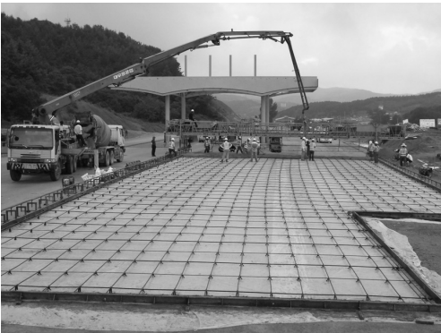
③ 테크피니셔에 의한 콘크리트 포설
