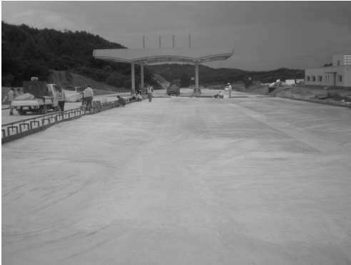
① PE시트 및 사이드폼 설치
