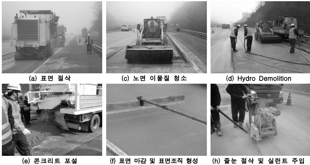
그림 6. 초속경 아크릴계 폴리머 개질 콘크리트 덧씌우기 시험시공 과정
