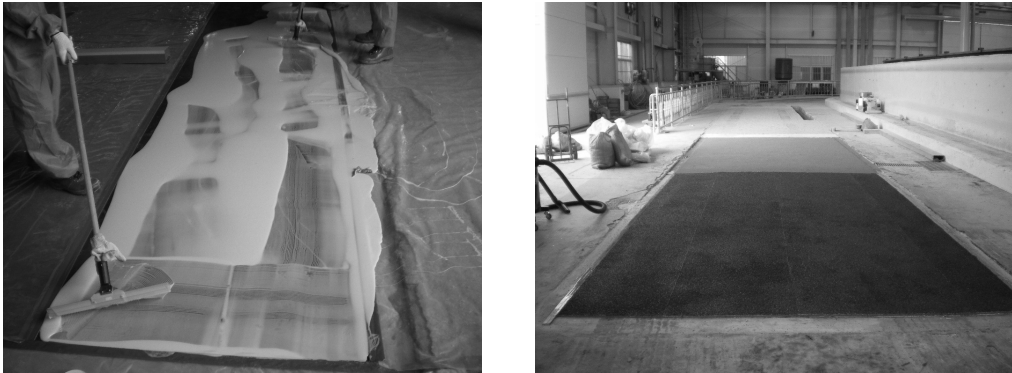
그림 3. 멤브레인층 포설 및 시공
