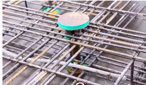
그림 2. 거푸집 제작 (a) 다웰바 포켓 설치 (b) 리프팅 및 레벨링 요소 설치
