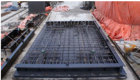
그림 3. 콘크리트 타설 전 완료된 거푸집
