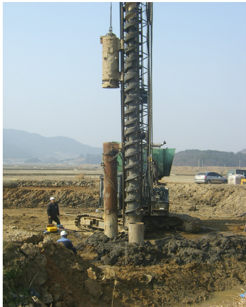
(b) Drop hammer - site Y
