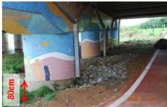
그림 5. 오산철교 교각 주변 세굴 모습
