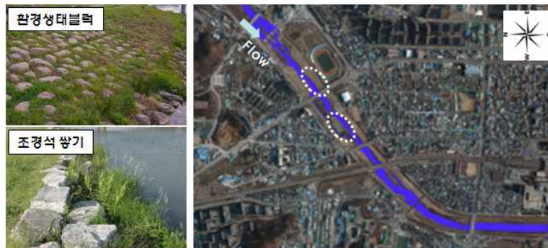
그림 6. 환경생태블럭과 조경석 쌓기 공법
