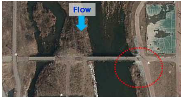
그림 10. 저수로내 설치된 인도교(목교)
