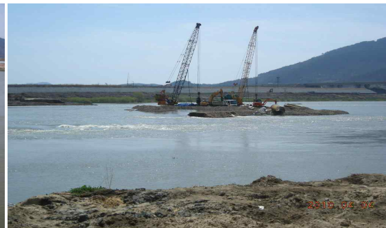
(b)골재채취를 위한 가물막이 설치
