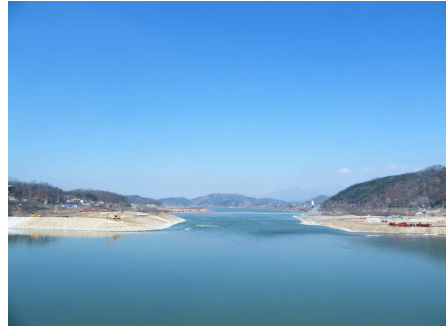
㉡ 이포 공사중 하류 전경
