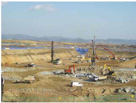
(a) 승천보 공사현장
