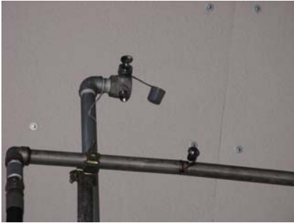
그림 3 설치된 실험대상 노즐들
