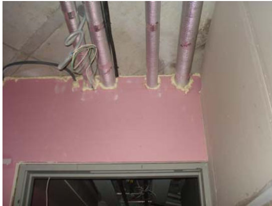
그림 4. 세대 출입문 상부 벽체 관통부
