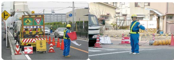
▶▶ 그림 2. 시내의 도로 공사현장
